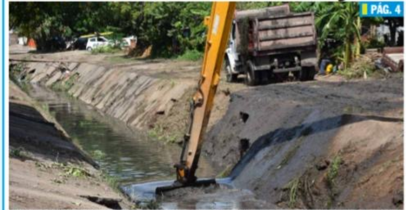
CD. LÁZARO CÁRDENAS, MICH. La Secretaría de Obras Públicas desazolva el canal de la avenida Francisco Noyola a fin de retirar la basura que arrastró la corriente de la pasadas lluvias.
