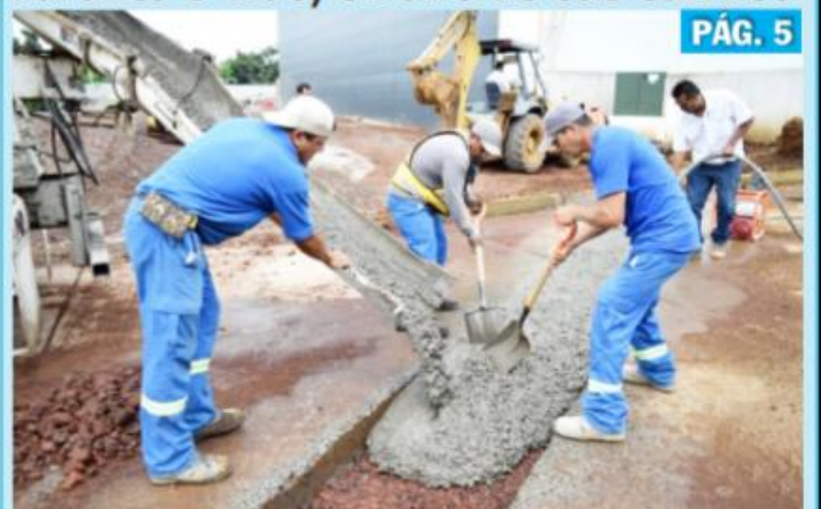
URUAPAN, MICH.- Por los trabajos para reponer el concreto hidráulico, permanecerá cerrada a la circulación vehicular, durante ocho días, uno de los carriles del Viaducto Jicalán.
