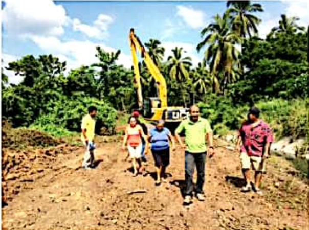
CD. LÁZARO CÁRDENAS, MICH.- Este martes arrancaron los trabajos de limpieza del canal de la Lucio Cabañas, a solo unos días de que fuera atendido el de la Noyola.
