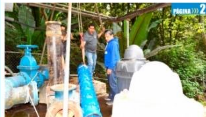
URUAPAN, MICH.- Personal de Capasu trabaja en la rehabilitación del segundo equipo de bombeo del manantial "El Pescadito", que se conectará a la línea de distribución "Los Pinos", y que abastece a más de 50 colonias del norte de la ciudad.
