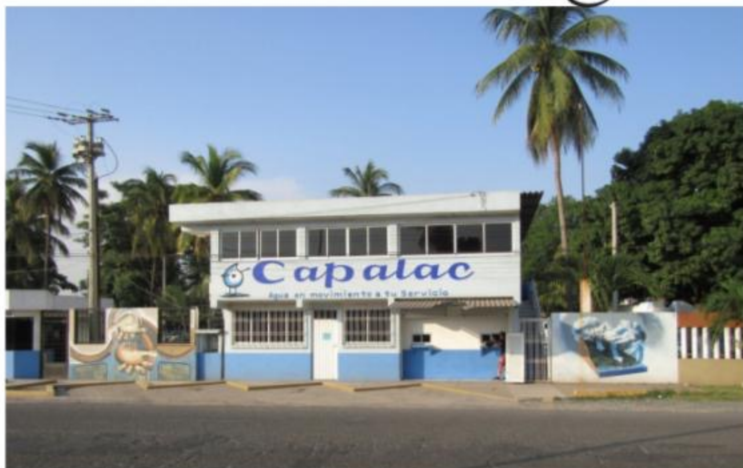
CD. LÁZARO CÁRDENAS, MICH.- La ciudad se quedó ayer sin agua por la ruptura en el tubo que conecta al acueducto industrial; fuentes del Capalac estimaron que el servicio sería restituido en el transcurso de hoy.
