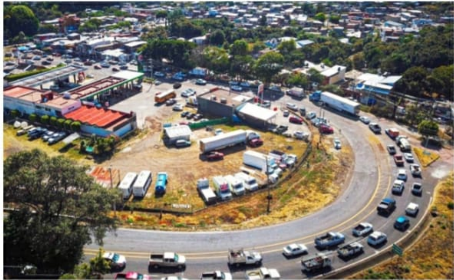
URUAPAN, MICH.- Hoy inician los trabajos de dos importantes obras de vialidad, una de ellas es el acceso norponiente a esta ciudad.
