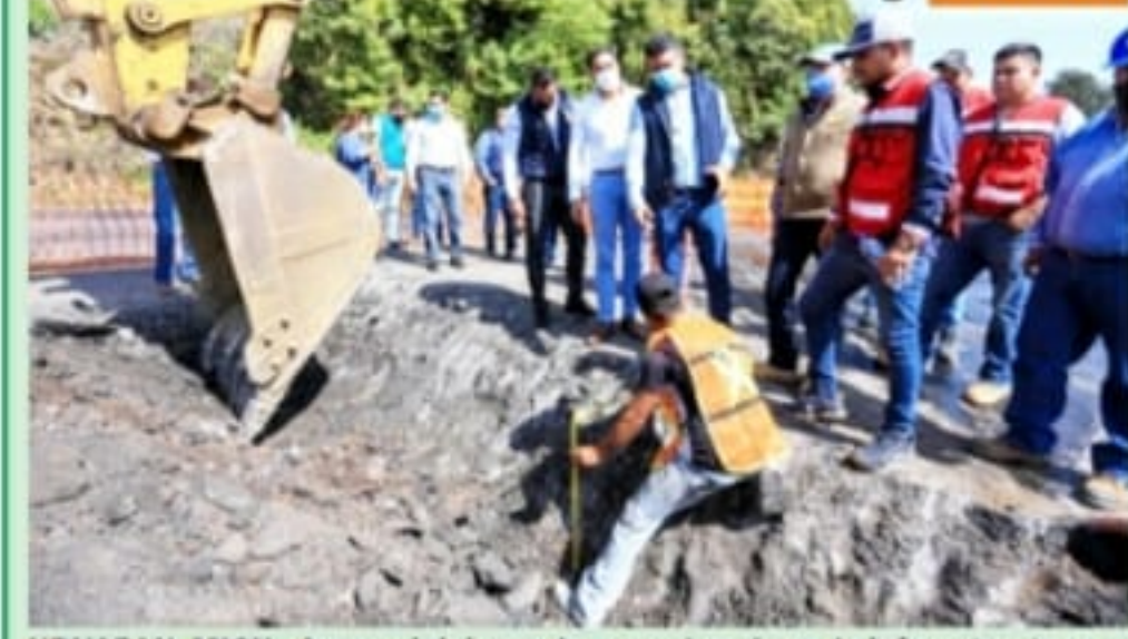
URUAPAN, MICH.- Ayer se iniciaron dos grandes obras de infraestructura en esta ciudad, para dar fluidez al tránsito de vehículos en tanto en el Libramiento Oriente como en la carretera a Paracho.
