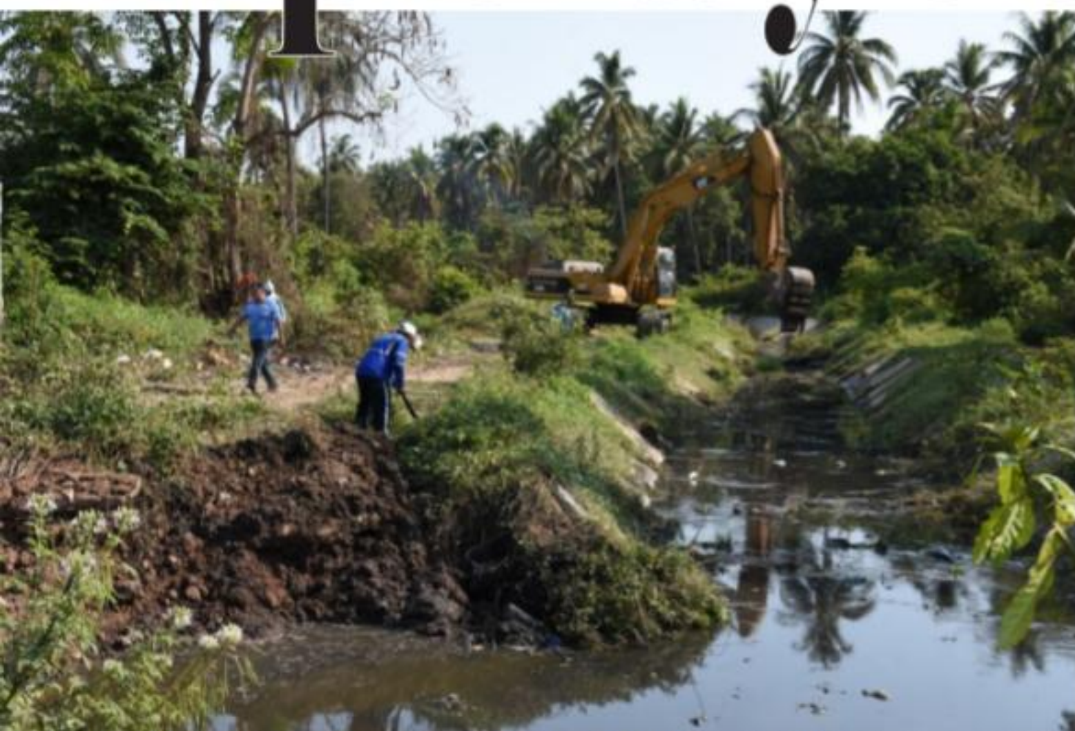
CD. LÁZARO CÁRDENAS, MICH.- La Secretaría de Obras Públicas y Desarrollo Municipal inició en la cabecera municipal los trabajos de limpieza y desazolve de los canales pluviales.
