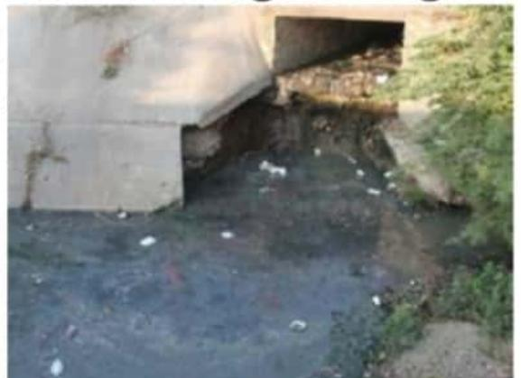
Una muestra del grave problema de contaminación por aguas residuales que hay en Lázaro Cárdenas, es el canal lluvia de la avenida Noyola, a donde descargan varias tomas de drenaje sanitario, en lugar de a algún colector.
