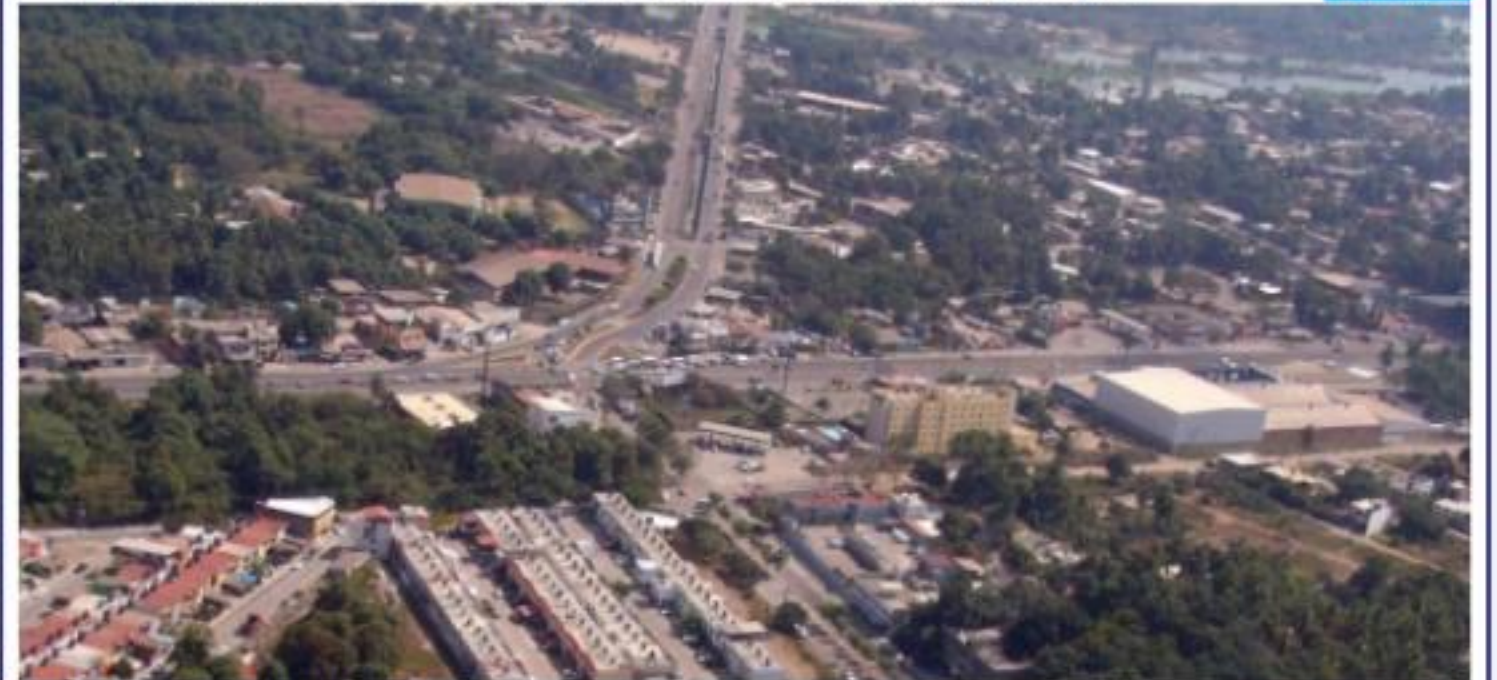
CD. LÁZARO CÁRDENAS, MICH.- La Secretaría de Obras Públicas Municipales continúa trabajando en la rehabilitación de las rutas alternas que ayudarán al desahogo del flujo vial.
