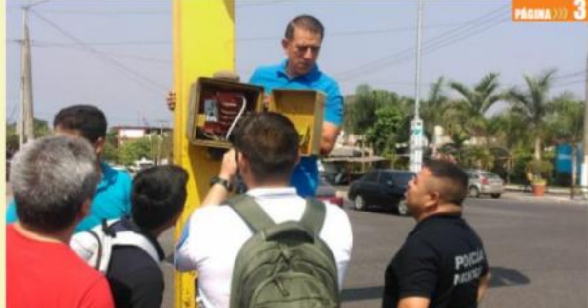
CD. LÁZARO CÁRDENAS, MICH.- Con el apoyo del Gustavo Morales Cervantes, regidor de Vialidad y Tránsito, la Delegación de Tránsito Estatal y el Departamento de Alumbrado Público realizaron el cambio de 18 lámparas en diferentes semáforos de la localidad.
