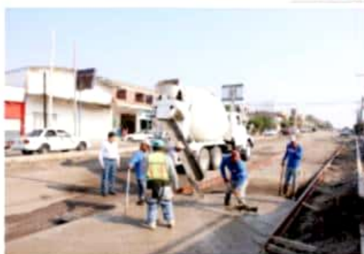
NUEVA ITALIA, MPIO. DE MÚGICA, MICH.- Avance significativo presenta la modernización de la avenida Lázaro Cárdenas en esta localidad, trabajos que fueron supervisados por el alcalde, Raymundo Arreola Ortega.
