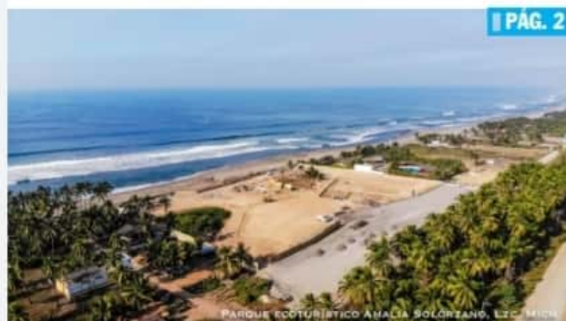
CD. LÁZARO CÁRDENAS, MICH.- La construcción del Parque Ecoturístico "Amalia Solórzano", tiene un avance del 20 por ciento en los trabajos de edificación.
