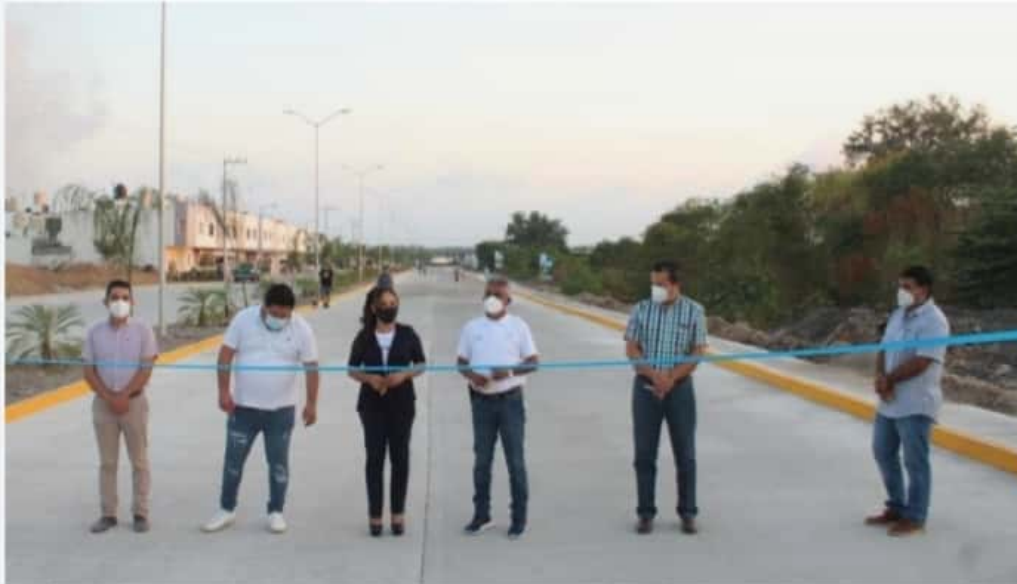
CD. LÁZARO CÁRDENAS, MICH.- Autoridades municipales e integrantes del Fideicomiso 752, inauguraron la pavimentación con concreto hidráulico, como parte de los trabajos de continuación de la Avenida Narciso Bassols, a través del Fideicomiso 752.
