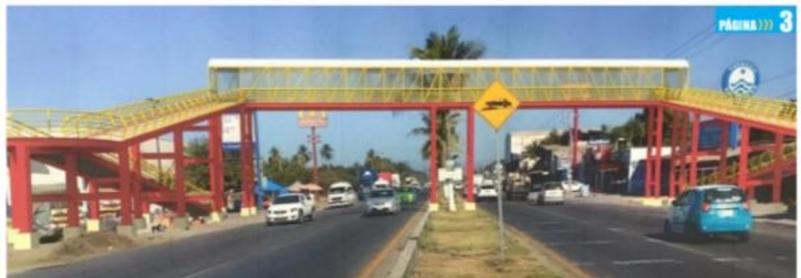
CD. LÁZARO CÁRDENAS, MICH.- La presidenta municipal, María Itzé Camacho Zapiain, informó que la falta de permisos de SCT obliga a la reprogramación de construcción del puente peatonal para el próximo año.
