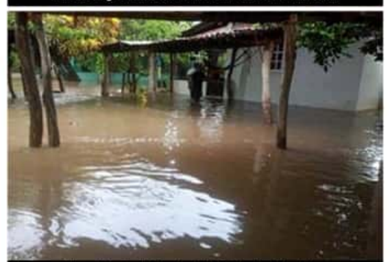
Algunas de las viviendas de la colonia La Pochota de Acalpican, ya se estaban inundando la tarde noche de ayer, por el desbordamiento del río Acalpican.
