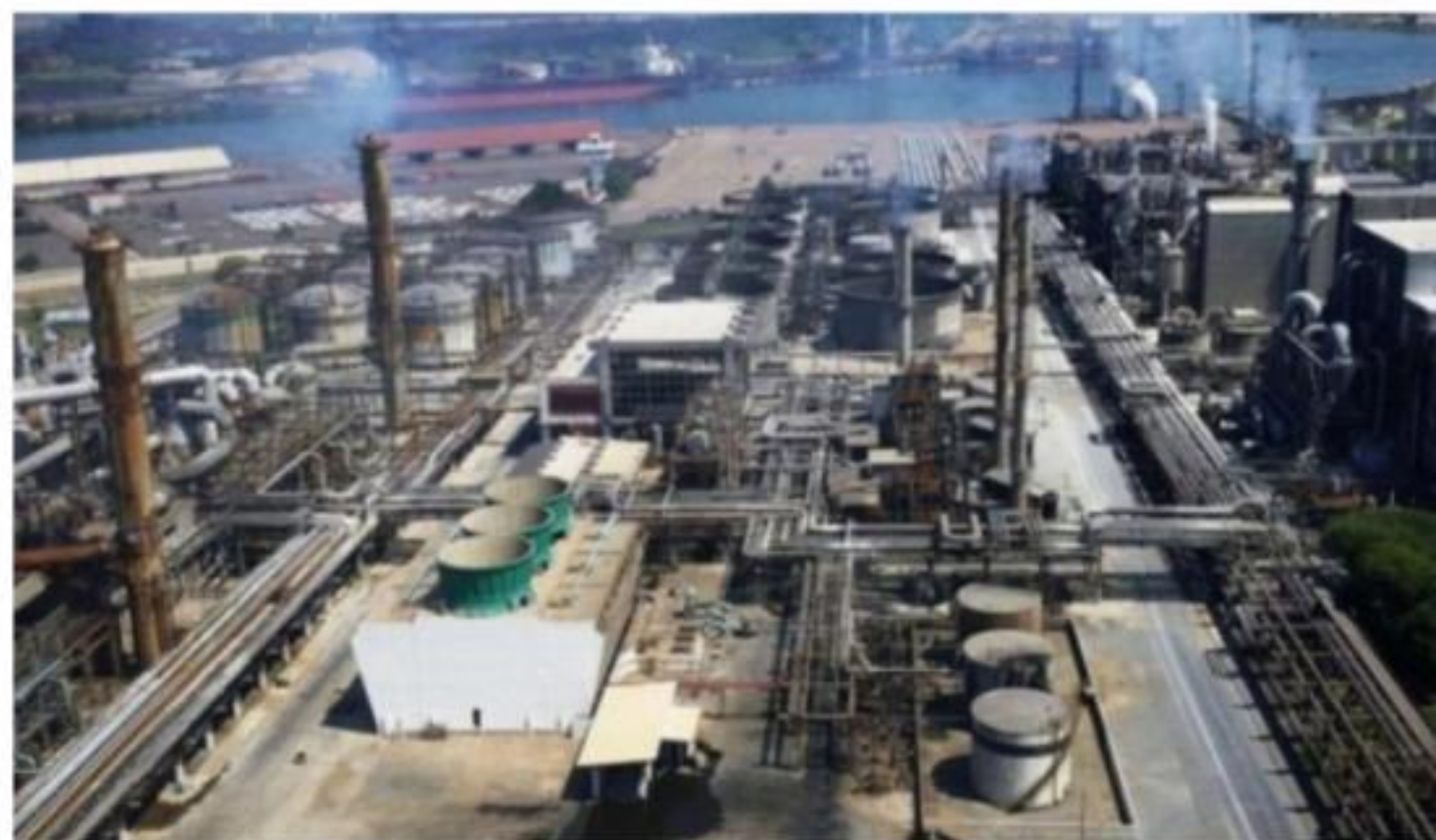
CD. LÁZARO CÁRDENAS, MICH.- La planta industrial que se conoce como Fertinal requiere elevar sus condiciones de seguridad y modernizar equipos para entrar en la etapa de mayor producción, expuso Javier Jaimes Chávila, delegado especial del Sindicato Minero.
