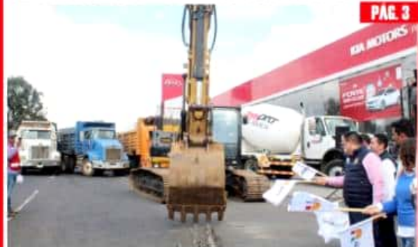
URUAPAN, MICH.- El presidente municipal, Víctor Manríquez, dio el banderazo para dar inicio a la reparación de un tramo del Libramiento Oriente.
