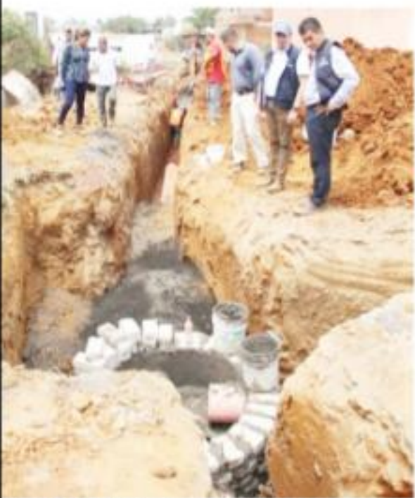
URUAPAN, MICH.- El secretario de Obras Públicas y Servicios, Jesús Mariano Torres Santoyo, y el coordinador general de la Comisión Estatal del Agua y Gestión de Cuencas (CEAC), Germán Tena Fernández, supervisaron la construcción de cuatro obras de agua potable y drenaje sanitario.
