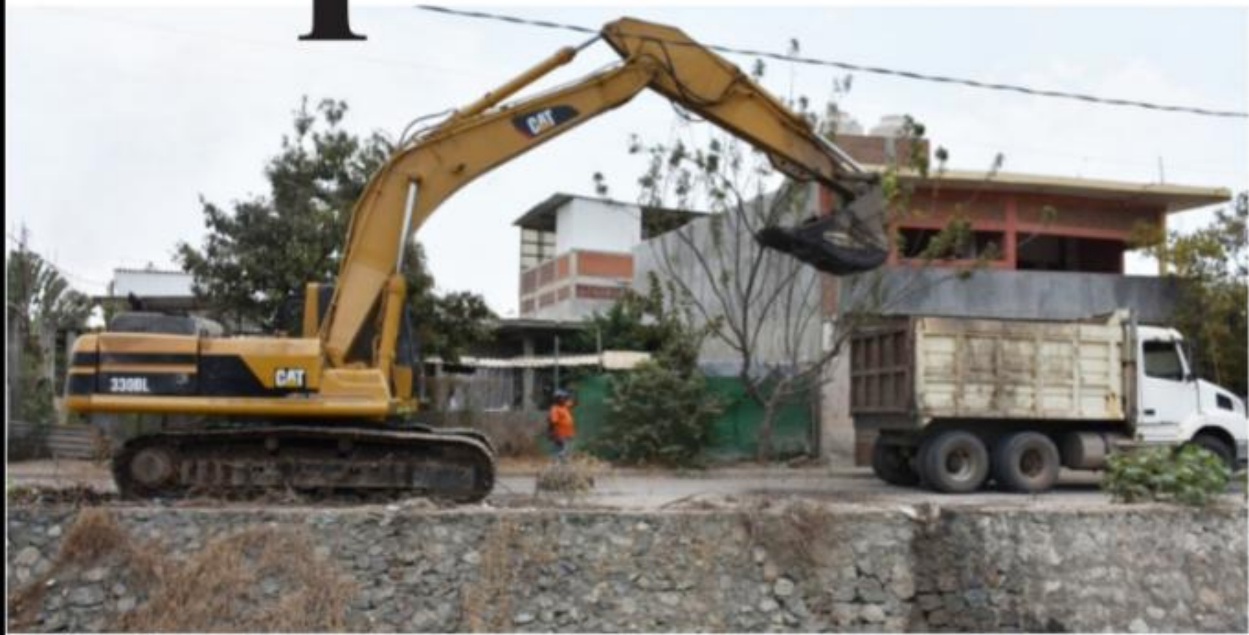
CD. LÁZARO CÁRDENAS, MICH.- Ayer iniciaron el desazolve del canal de la avenida Francisco Noyola, luego de concluir los trabajos de reparación de un tramo del mismo.
