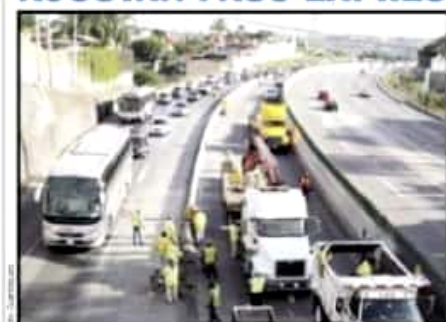
CUERNAVACA, Méx.- Ayer comenzó el retiro del muro divisorio del tráfago en esta autopista, un año tras el accidente mortal a 100 km/h.
