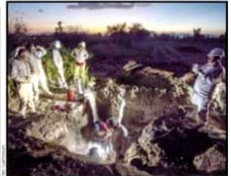
TLAHUELLPAN, Hgo.- Una cuadrilla de trabajadores de Pemex labora sin descanso para clausurar tomas clandestinas en los ductos de la paraestatal. No cesan los piquetes en toda la red nacional.
