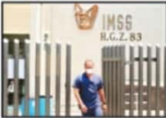
En zona contigua a la Unidad 83 en Morelia está instalado el hospital temporal COVID-19.
