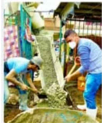
URUAPAN, MICH.- El alcalde Miguel Paredes Melgoza, cumple su palabra y personalmente participó en una primer jornada para la reconstrucción de la humilde vivienda que fue consumida por un incendio.
