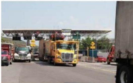
Mientras no se termina de reparar el tramo donde hace ya más de un año se formó un socavón en la mal llamada autopista siglo 21, la diputada Fanny Arreola, propuso que se deje de cobrar peaje en la caseta de Santa Casilda.
