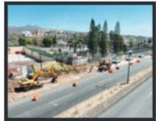
HASTA UN AÑO DURARÍA LA CONSTRUCCIÓN DEL PASO VEHICULAR DE VILLAS DEL PEDREGAL.
