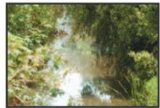
Ayuntamiento hace trabajos de desazolve.
