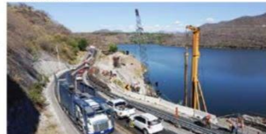
El gobernador Alfredo Ramírez Bedolla, realizó ayer un recorrido de supervisión de los trabajos de reparación del llamado socavón que se hizo en el 2021, en la autopista siglo 21.
