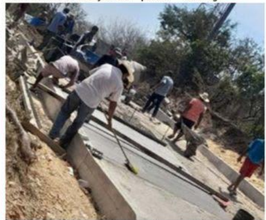
Habitantes de El Bejuco, colaboraron con la mano de obra para mejorar una nueva vialidad en esa comunidad.
