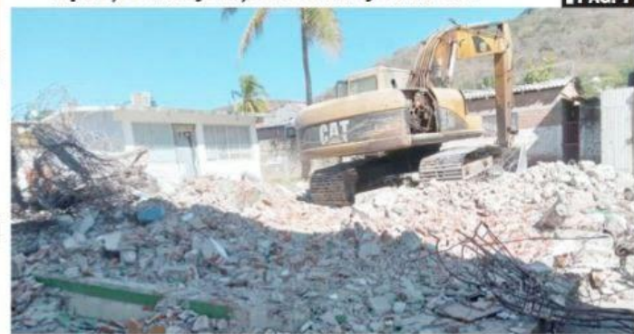
COAHUAYANA, MICH.- La Secretaría de Comunicaciones y Obras Públicas de Michoacán informó que ya empezó a trabajar en la reparación de infraestructura educativa afectada por
