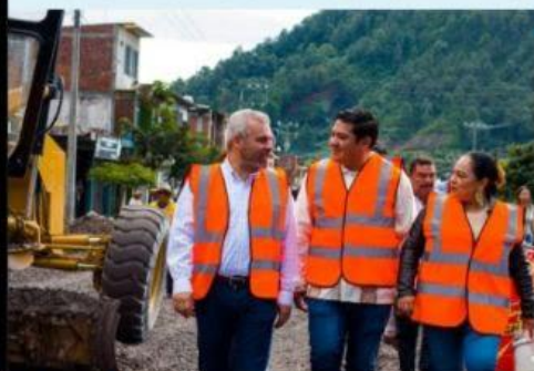
NUEVO PARANGARICUTIRO, MICH.- El gobernador Alfredo Ramírez Bedolla supervisó la realización de obra pública en este municipio.
