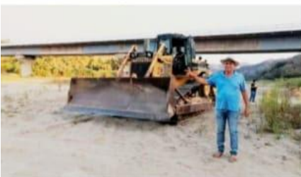
CD. LÁZARO CÁRDENAS, MICH.- Con el objetivo de evitar problemas de desbordamientos e inundación de viviendas, así como para el resguardo de diferentes cultivos de esa zona, van dando comienzo las labores de desazolve del río Acapulcan.
