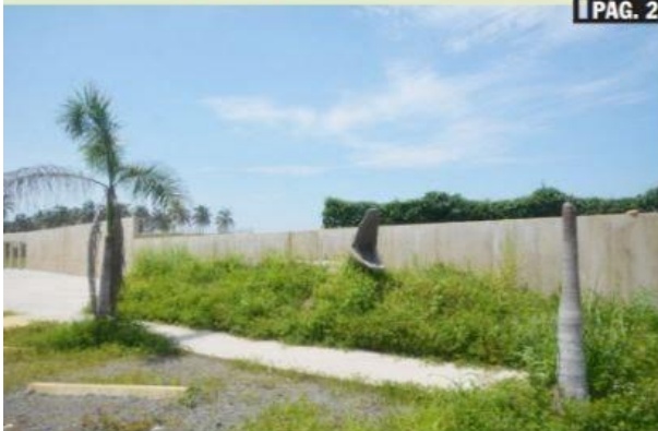
D. LÁZARO CÁRDENAS, MICH.- El parque eco turístico espera tiempos mejores, y pronto se reactivarán los trabajos de desarrollo de esta obra, ubicada en playa ortuga.
