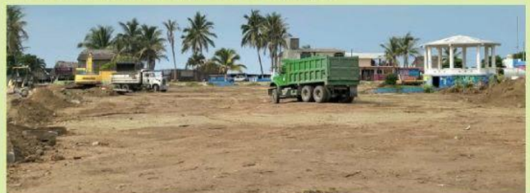
CD. LÁZARO CÁRDENAS, MICH.- El presidente municipal de Lázaro Cárdenas, Manuel Esquivel Bejarano, informó sobre el avance que guardan algunas obras que serán inauguradas en este gobierno municipal, como es la primera etapa de la remodelación de la plaza de la tenencia de Playa Azul.
