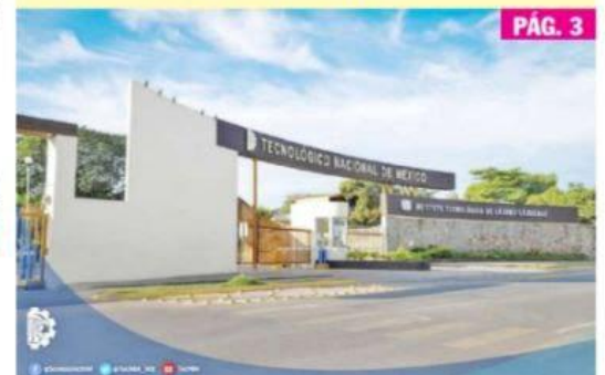
CD. LÁZARO CÁRDENAS, MICH.- Las instalaciones del Instituto Tecnológico de Lázaro Cárdenas se vieron vulneradas ayer, cuando personas ajenas a la institución ingresaron con maquinaria pesada para llevar a cabo trabajos de limpieza en terrenos propiedad de la institución.
