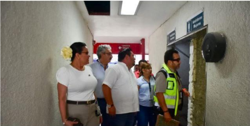
CD. LÁZARO CÁRDENAS, MICH.- Autoridades municipales y del IMSS supervisan las obras en el área de hospitalización y laboratorio del HGZ-MF No. 12, en beneficio de los derechohabientes de Lázaro Cárdenas.
