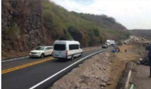
De acuerdo con el organismo Merecs que impulsa la ampliación a 4 carriles de la mal llamada autopista Siglo 21, la concesionaria sí está obligada a hacer esta obra, porque así lo contempla el contrato que tiene.
