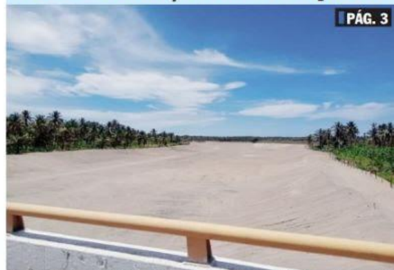
CD. LÁZARO CÁRDENAS, MICH.- Aun cuando ya está desazolvado el río Acalpican, la alcaldesa Itzé Camacho Zapalán, consideró que una solución para acabar con los desbordamientos de este río, es el enrocamiento del mismo, el cual por su alto costo, tendría que ser una obra que efectuó el gobierno federal.
