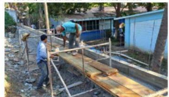
El Cobaem informó que ya fueron concluidos los trabajos de un muro de contención en el plantel de La Mira, para evitar futuras inundaciones.
