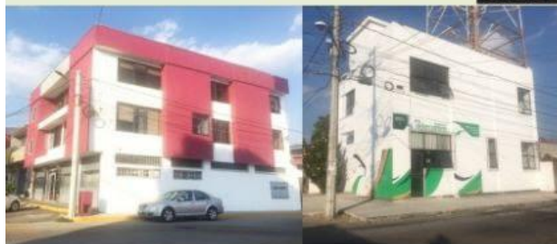
URUAPAN, MICH.- Gestiones realizadas por el alcalde, Nacho Campos, permitirán dejar de pagar renta en el edificio que durante años ocupó la Secretaría de Obras Públicas, en la avenida Chiapas, al reubicarse en un inmueble que Telecom le cedió en comodato, en la calle Prolongación Gran Parada.
