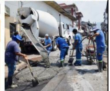
URUAPAN, MICH.- Personal de la Capasu aplicó 4.5 metros cúbicos de concreto hidráulico en la calle 5 de Febrero, en el centro histórico de esta ciudad, concluyendo así la rehabilitación de la red general de drenaje sanitario.
