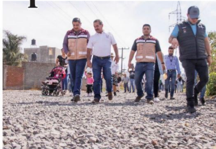
URUAPAN, MICH.- El presidente municipal, Nacho Campos Equihua, supervisó la rehabilitación de la avenida de Las Torres, localizada al extremo oriente de la ciudad.
