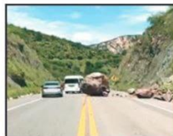
En carreteras de la entidad se generaron desprendimientos de rocas a causa del sismo.
