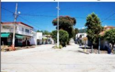
URUAPAN, MICH.- Esta semana serán oficialmente entregados trabajos de pavimentación en diferentes calles como la Francisco Villa, Niños Héroes, Yucatán, Prolongación Nicolás Romero y Jalisco.
