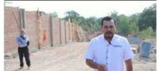
En Aquila dieron inicio los trabajos de construcción de las instalaciones de la Universidad Politécnica, Tecnológica e Intercultural.
