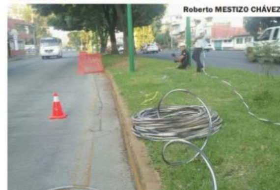
URUAPAN, MICH.- Inició el cableado para suministrar energía eléctrica a la nueva red de alumbrado público de la calzada Benito Juárez.
