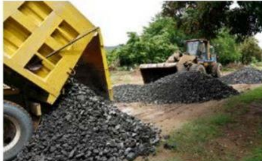
ArcelorMittal México finaliza trabajos de desazolve en la colonia Valle Bonito, e inicia rehabilitación con gravilla, en diversas calles de tenencia La Mira.
