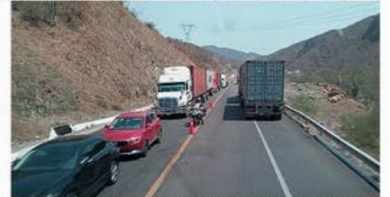
Uno de los tramos complicados para todo tipo de vehículos, es el cercano al puente Infiernillo 3 que divide a Michoacán con Guerrero, donde se reduce el paso a un solo carril sobre dicho puente, que sigue en reparación.
