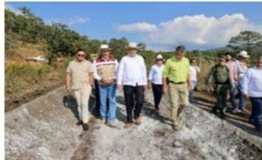
El gobernador Bedolla supervisó el avance de obras en la región de Tierra Caliente de Michoacán.
