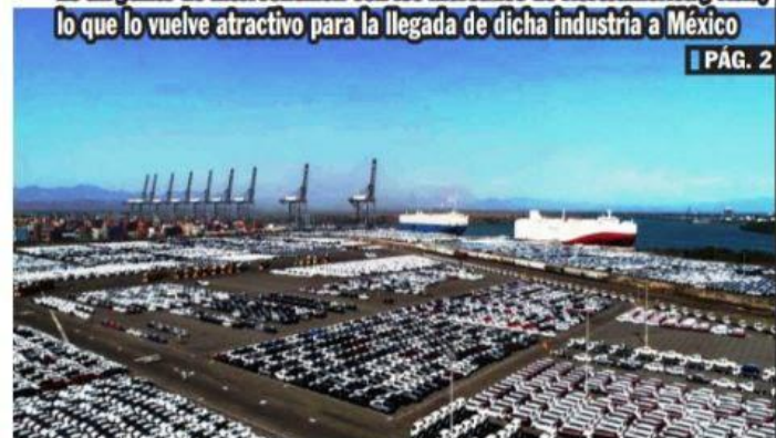
CD. LÁZARO CÁRDENAS, MICH.- El Puerto de Lázaro Cárdenas, considerado el puerto de México, es la mejor opción en el país para la instalación de la planta de Tesla, destaca la presidenta municipal, Itzé Camacho.
