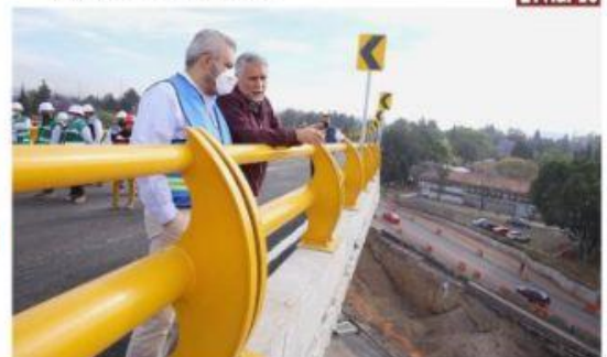
MORELIA, MICH.- El mandatario estatal, Alfredo Ramírez Bedolla, dio apertura al puente elevado del distribuidor vial de la salida a Salamanca.
