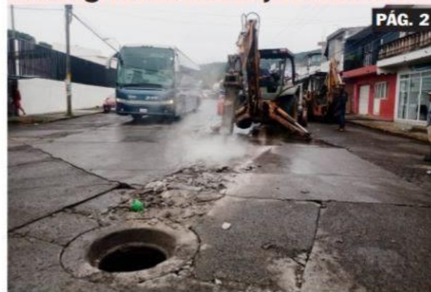
URUAPAN, MICH.- Capasu realiza la reparación emergente drenaje sanitario que
